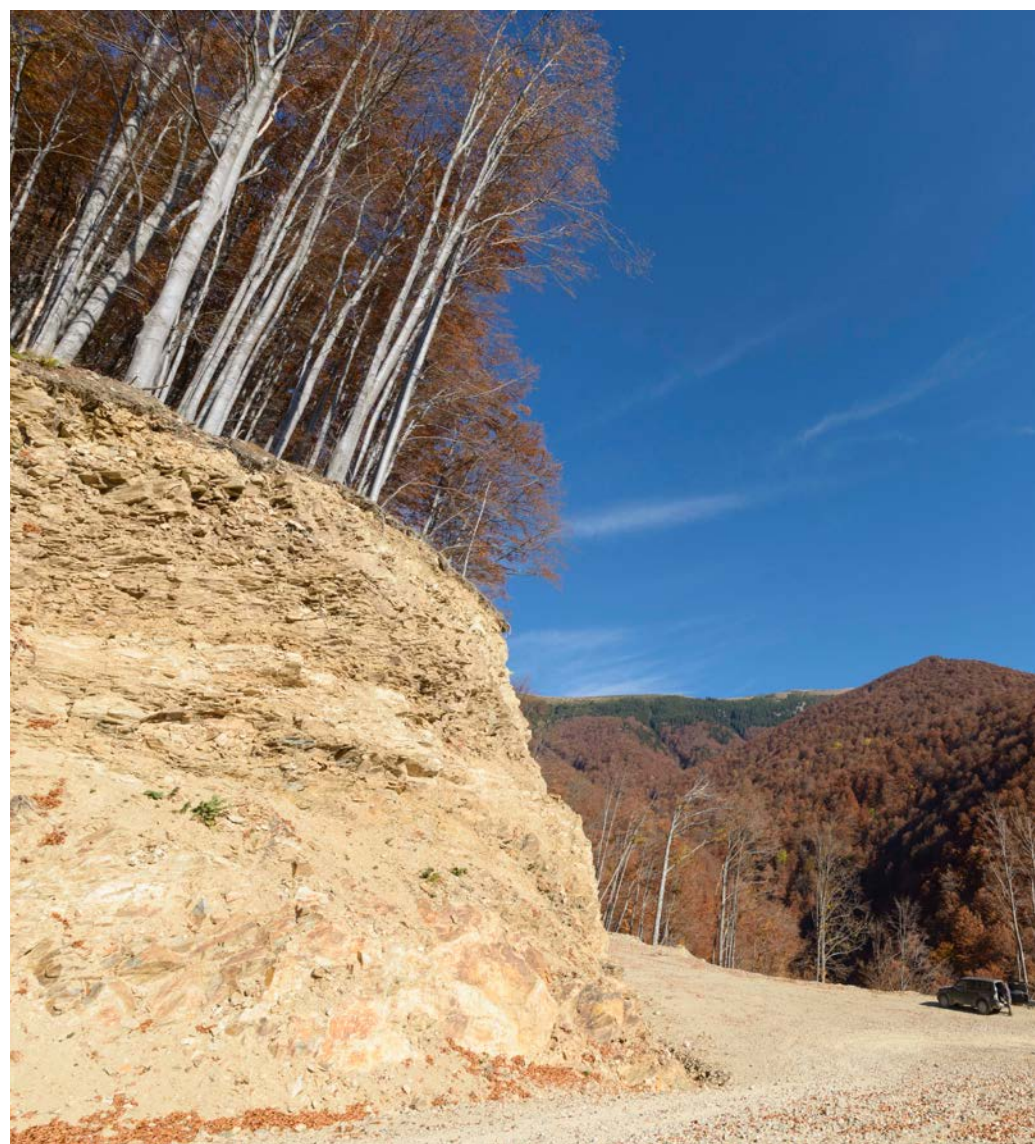
Construcție de drum cu finanțare UE într-o vale neatinsă din Munții Vâlcan, în situl Natura 2000 Nordul Gorjului de Vest.
