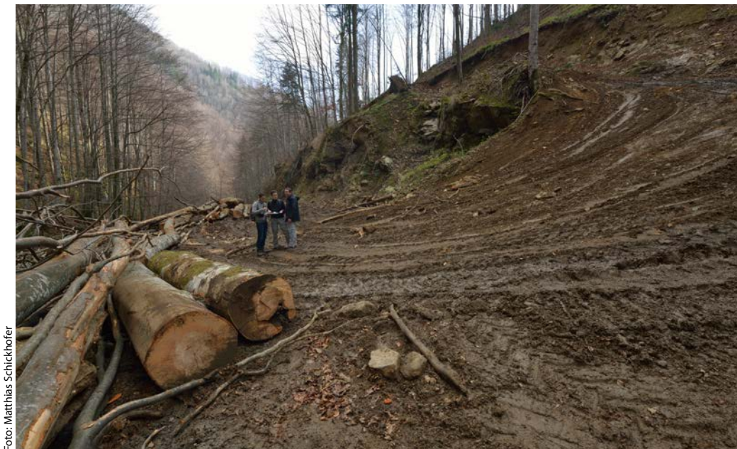
Foto: Matthias Schickhofer Drum de exploatare creat cu buldozerul în zona tampon a unui sit din Patrimoniul Mondial UNESCO în Parcul Național Domogled-Valea Cernei.
